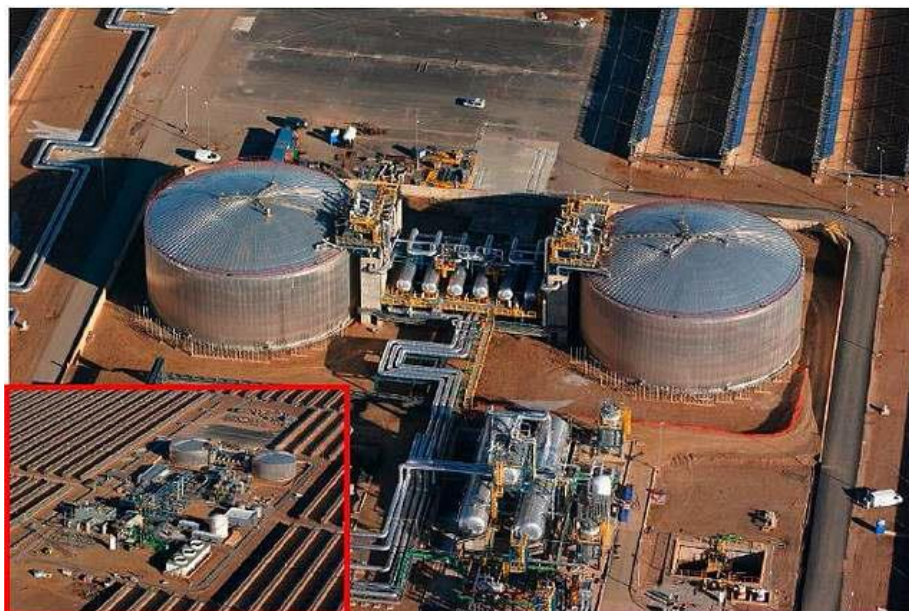
Εικόνα 3.3: Το σύστημα αποθήκευσης θερμότητας δύο δεξαμενών του Andasol [16]
