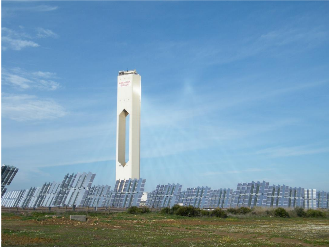
Εικόνα 2.2: Εγκατάσταση Ηλιακού Πύργου PS10 [13]
