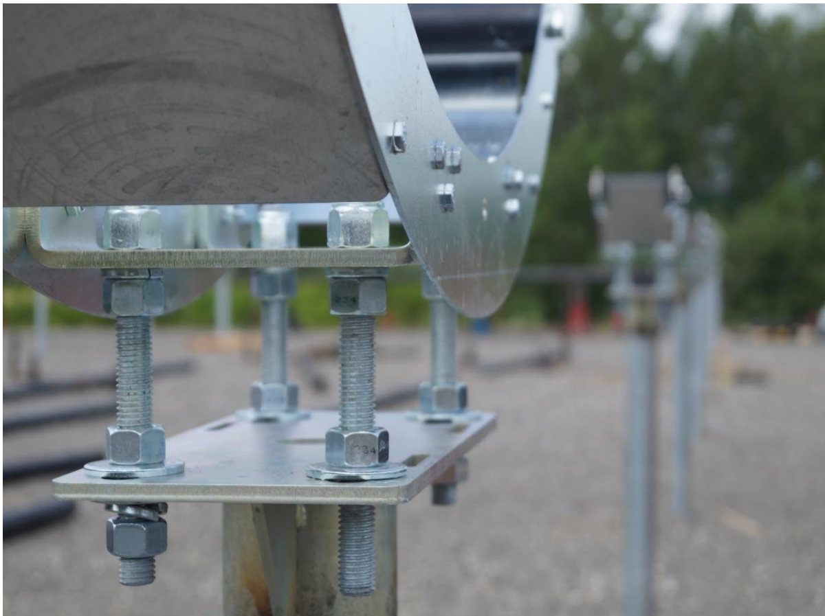
Εικόνα 4.2: Τμήμα Βάσης Εγκατεστημένου Κοίλου Παραβολικού Συλλέκτη
