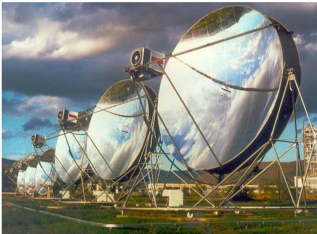
Εικόνα 2.3: Παραβολικοί δίσκοι μηχανής Stirling (Plataforma Solar de Almeria) [13]
