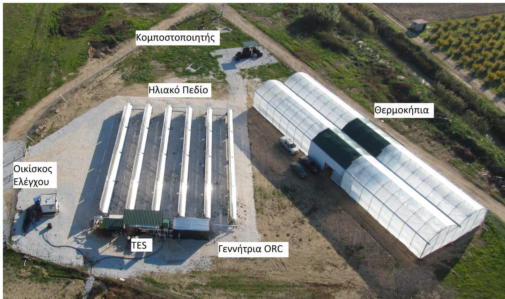
Εικόνα 4.1: Αεροφωτογραφία του πιλοτικού έργου «ENERGEIA»
