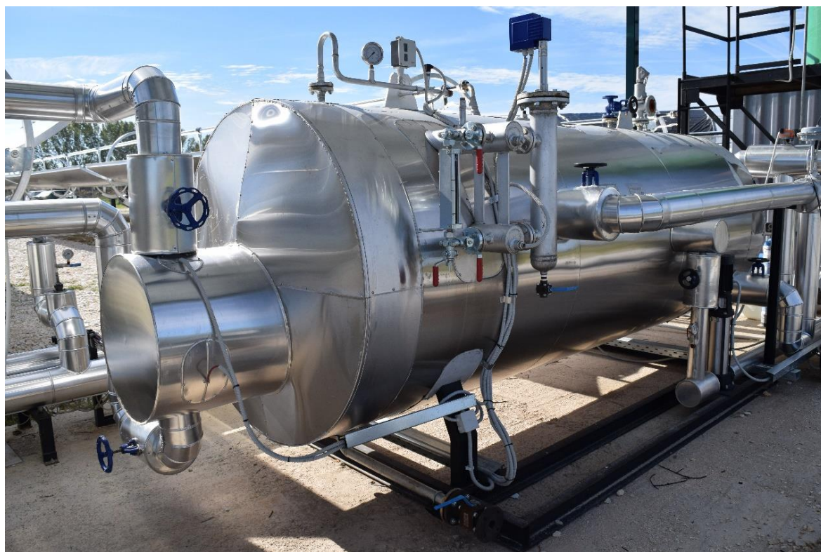
Εικόνα 4.4: Σύστημα αποθήκευσης θερμικής ενέργειας (TES)
