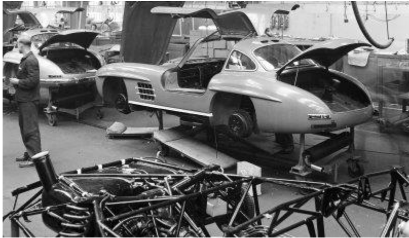
Σχήμα 1.17: Παραγωγή σωληνωτού πλαισίου του SL 300
