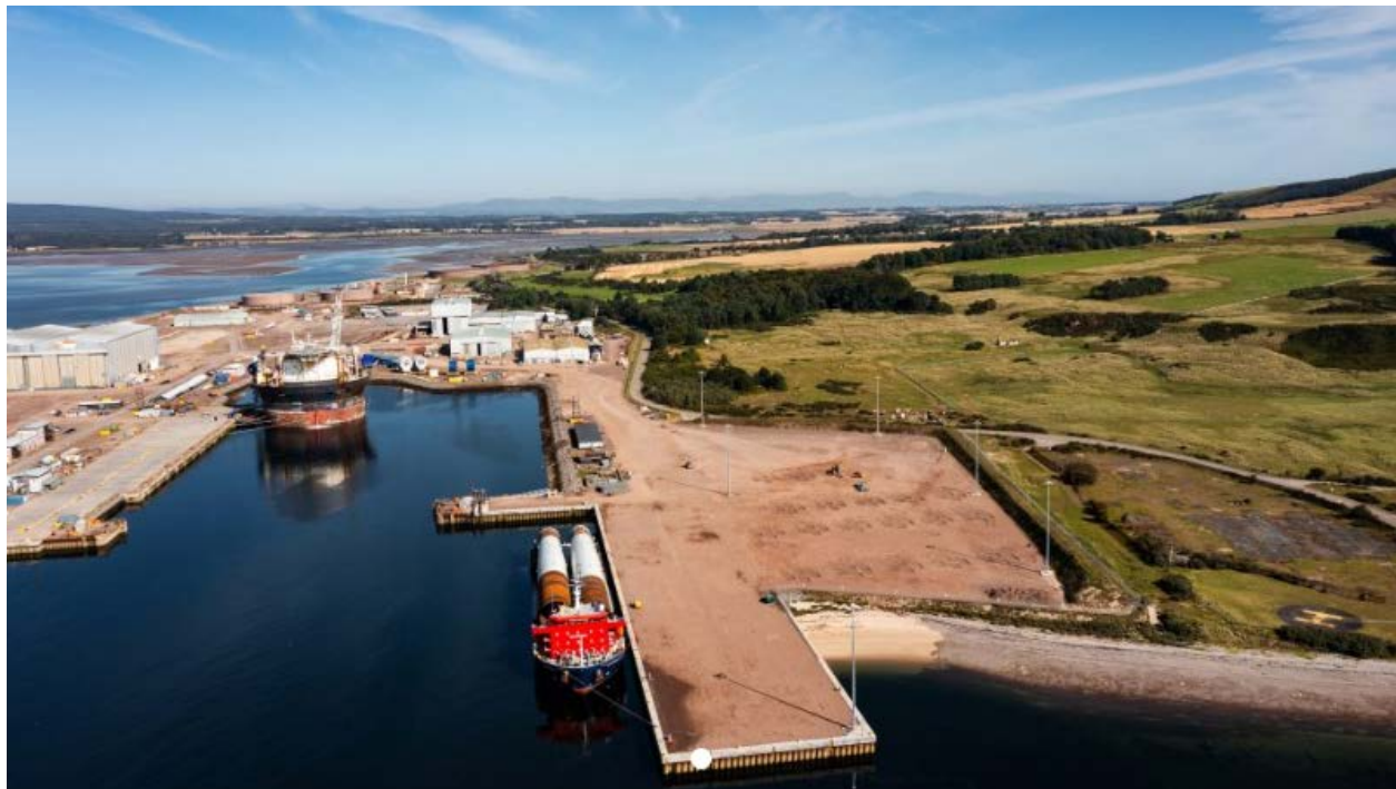
Σχήμα 2.2: Λιμενική εγκατάσταση συναρμολόγησης υπεράκτιων ανεμογεννητριών στην Ανατολική προβλήτα του λιμένα Νιγγ της Σκωτίας, [2.2]
