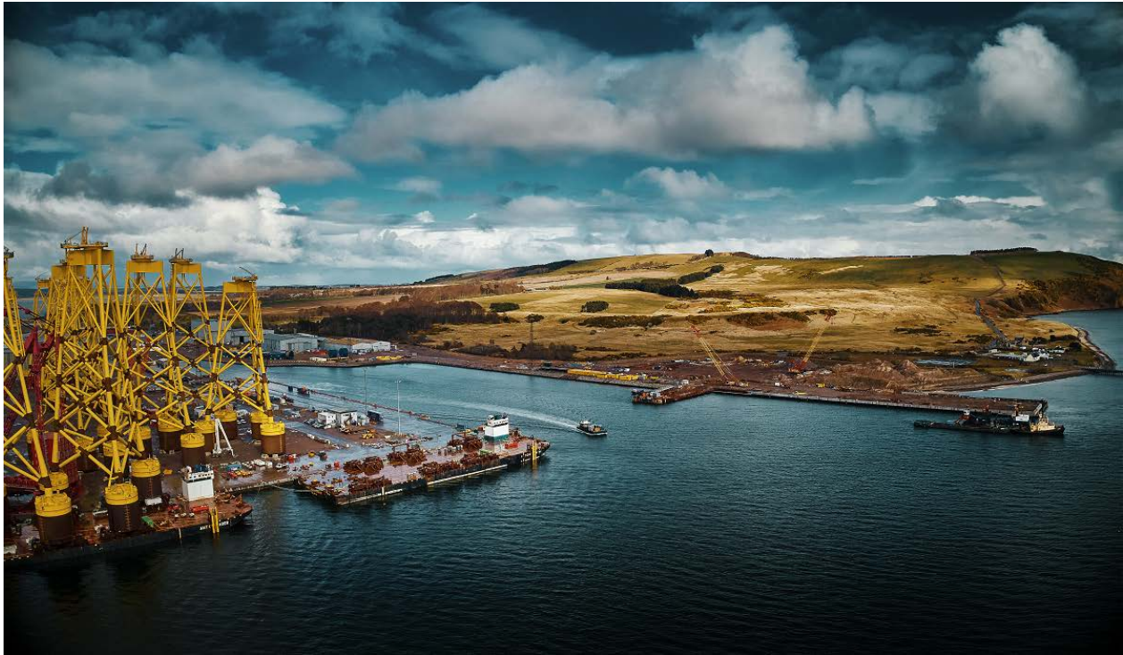
Σχήμα 2.3: Οι λιμενικές εγκαταστάσεις του λιμένα Νιγγ της Σκωτίας, [2.1].
