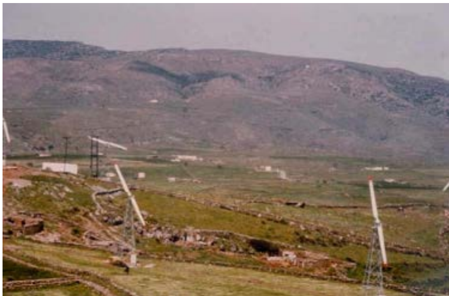
Σχήμα 1.1: Τα έργα εγκατάστασης του αιολικό πάρκου της Κύθνου το 1982, [1.2].
