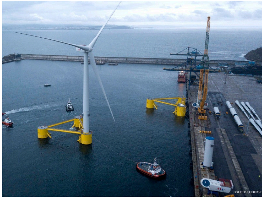
Σχήμα 2.4: Η διαδικασία ρυμούλκησης υπεράκτιας ανεμογεννήτριας, [2.3]
